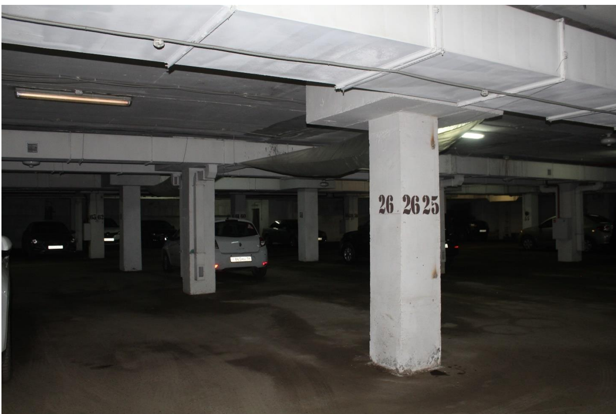
Фото 5, 6. Общие виды подземной автомобильной парковки
