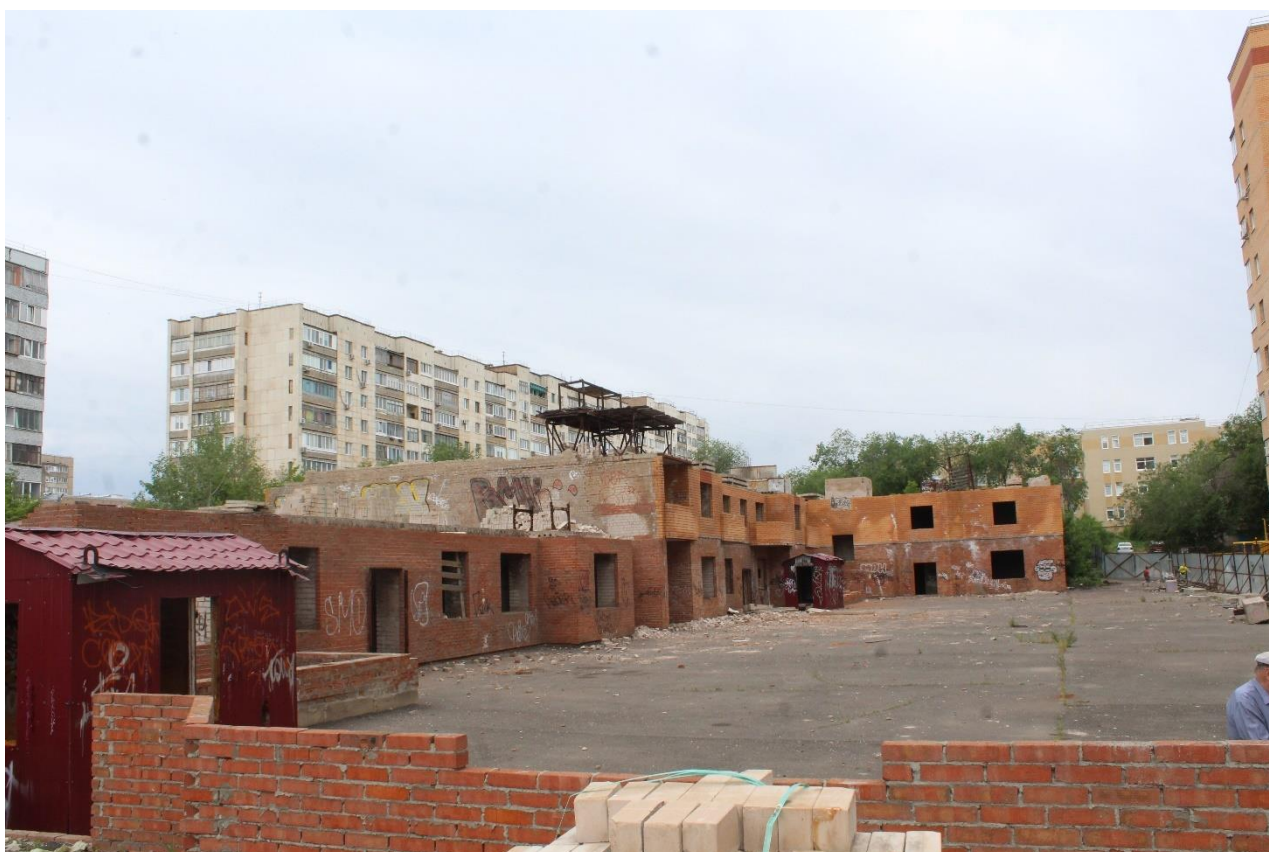
Фото 1, 2. Общие виды объекта незавершённого строительства с кадастровым номером 56:44:0224004:595
