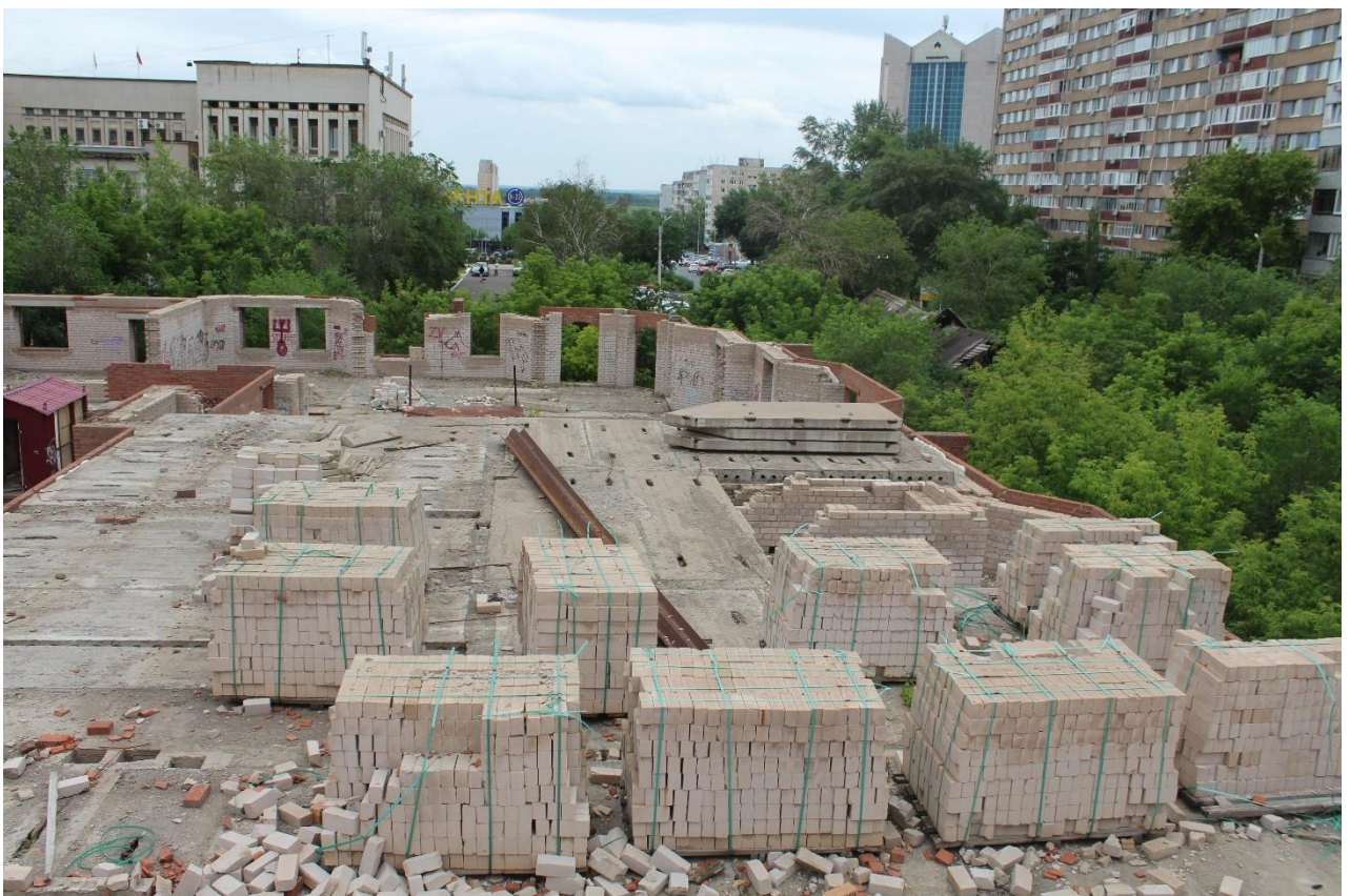
Фото 3, 4. Общие виды объекта незавершённого строительства с кадастровым номером 56:44:0224004:595
